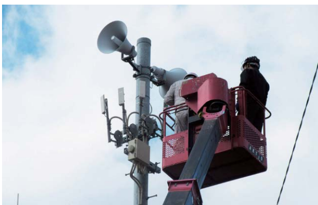
街頭防犯カメラ無線アンテナ設置施工写真
