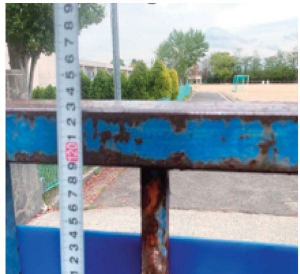
正門の高さを測っているところ
