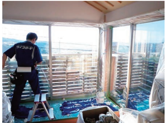
防犯フィルムの施工風景
